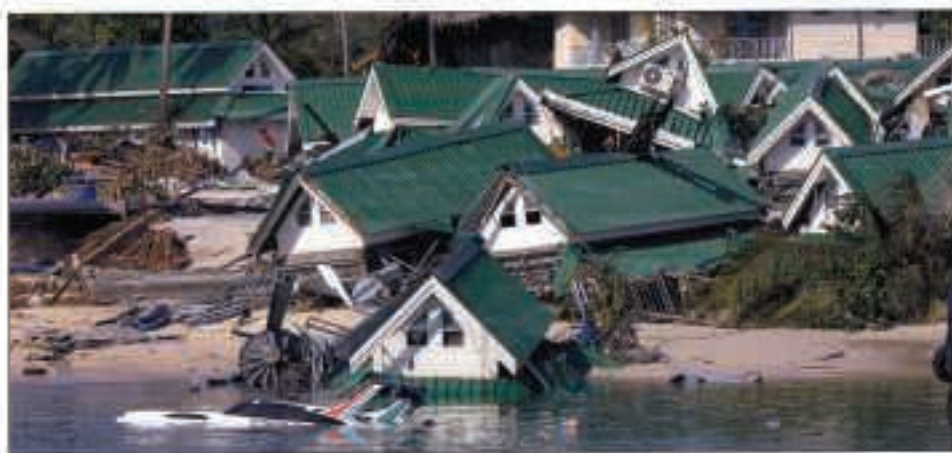
Hus som blivit förstörda av tsunamin.
